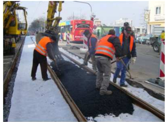
Frankfurt am Main: ATS 0/32 30/45 temperaturreduziert im Handeinbau bei 3°C Außentemperatur
