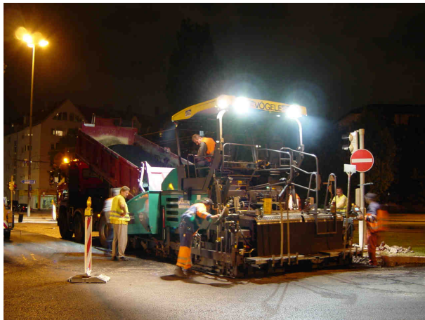
Niedrigtemperatur-Asphalt im Nachteinbau
